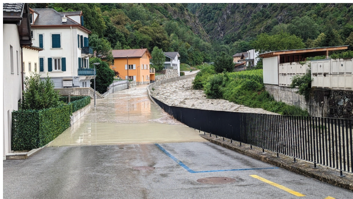
Inondation de la Navisence à Chippis, juin 2024.
